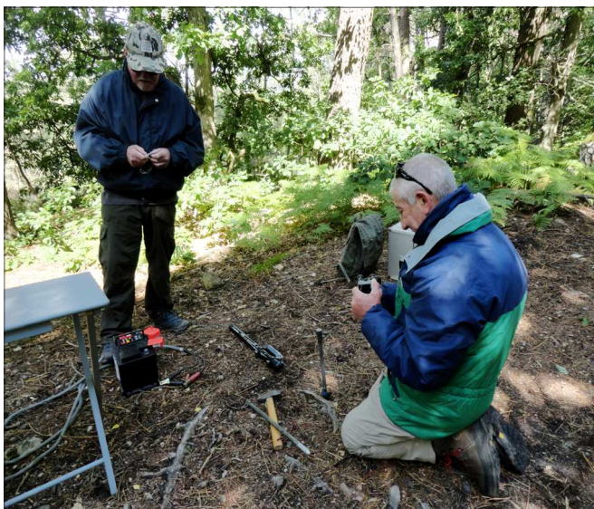
André F6IGY. Mise en place support pied mât antenne
